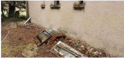
Les murs extérieurs présentent un crépi classique avec des fissures visibles par endroits, ce qui peut poser des problèmes d'infiltration d'eau et de dégradation.
