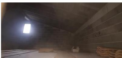
Les combles visibles montrent une isolation insuffisante ou inexistante, ce qui contribue à des pertes thermiques importantes.
