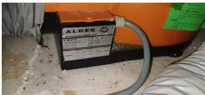
Le système de ventilation mécanique (type Aldes VMPK) est essentiel pour renouveler l'air dans le logement. Cependant, les conduits semblent abîmés ou mal installés (isolation insuffisante).
